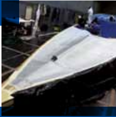
Construction du pont chez JMV (Cherbourg)
