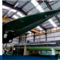
Assemblage du pont et de la coque
